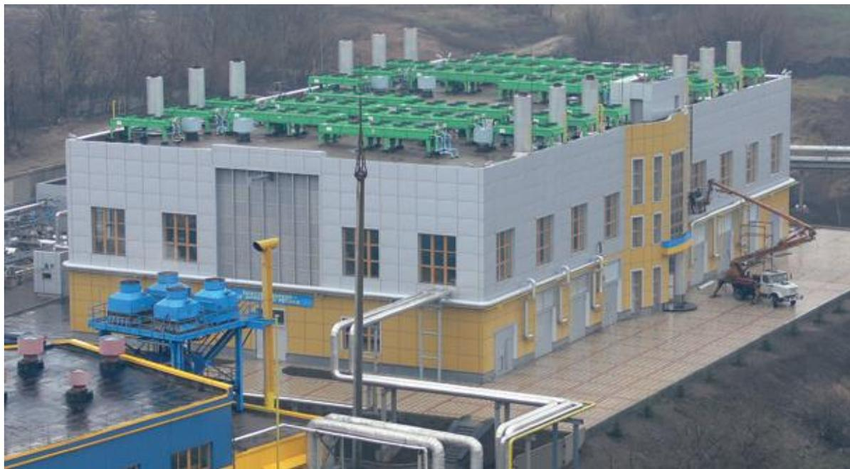
Рис.2. ТЭС шахты «Засядько», утилизация дегазационного метан
